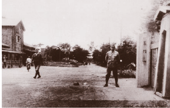
昭和20年以前 東京瓦斯電気工業立川工場 日立航空機株式会社裏門
